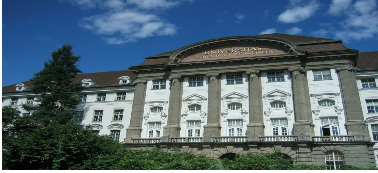
Κεντρικό κτήριο του Πανεπιστημίου του Innsbruck.
